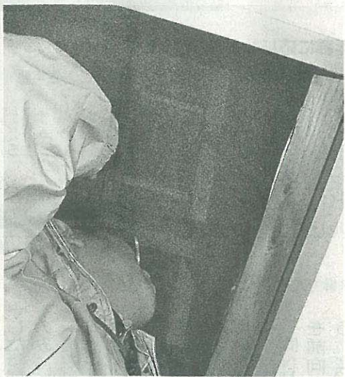
天井裏。雨漏りやシロアリの痕跡がないかを見る
