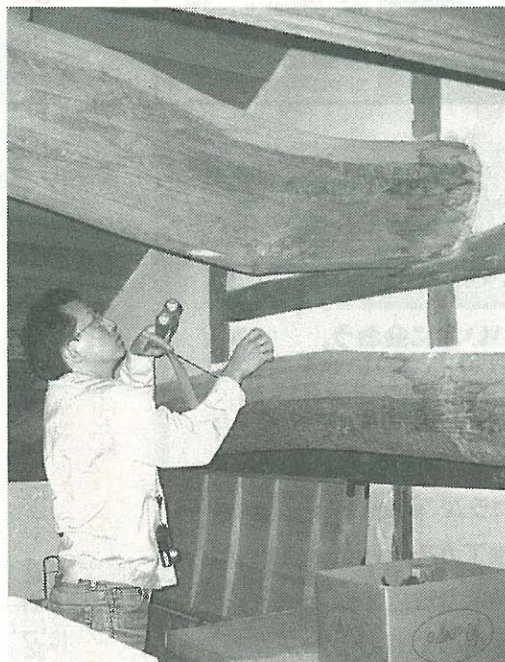
家の屋根裏で雨漏りの原因を調査する伊藤裕啓さん
